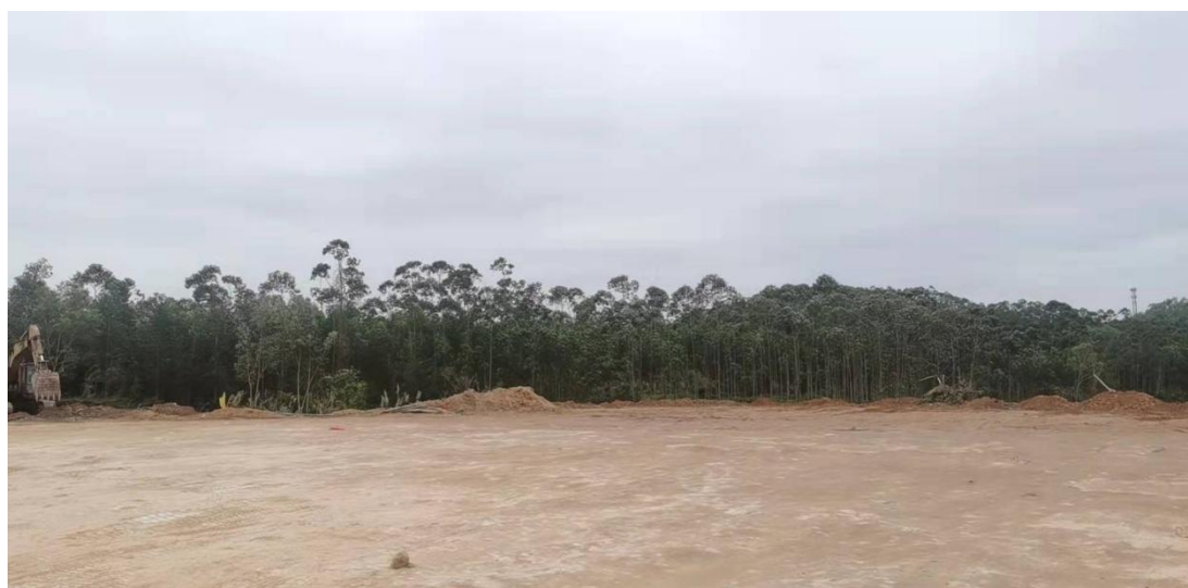
项目东面-空地
